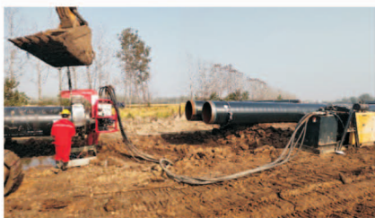
图 3 坡口机液压站装置
