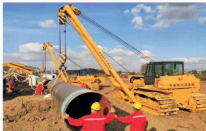
图 1 湿地吊管机现场施工图
