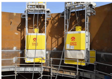
图 1 埋弧自动横缝焊机
