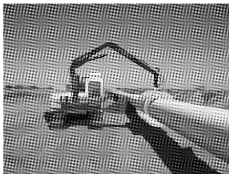
图 1 VPL 光纤激光焊接系统现场施工照片
