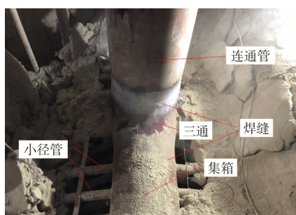
图 2 三通连接示意图
